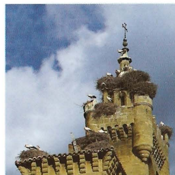
Torre de la Iglesia del Salvador de Ejea
